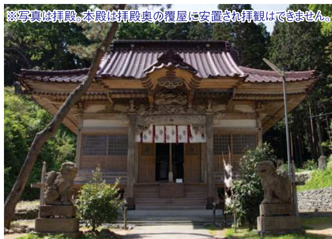
※写真は拝殿。本殿は拝殿奥の覆屋に安置され拝観はできません。
