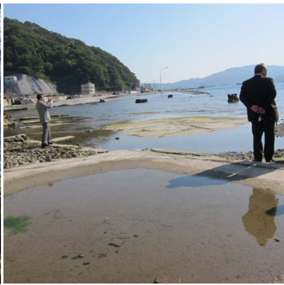
沈下した漁港
