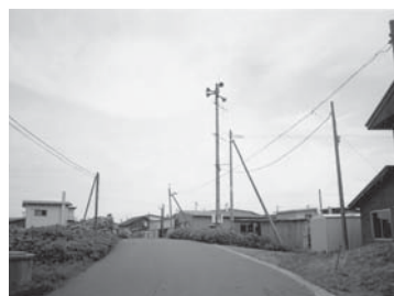
改修を行う石崎中継局
