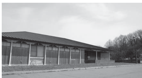
改修を行う勝山館ガイダンス施設
