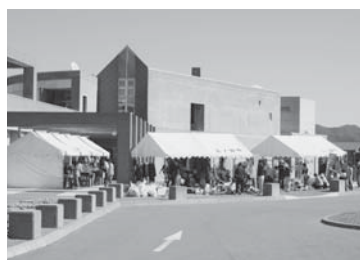
冷暖房の改修を行う道の駅「もんじゅ」
