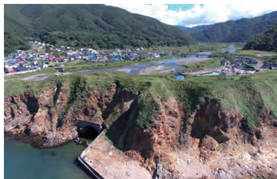
現在の漁港トンネルの様子（外海から）
