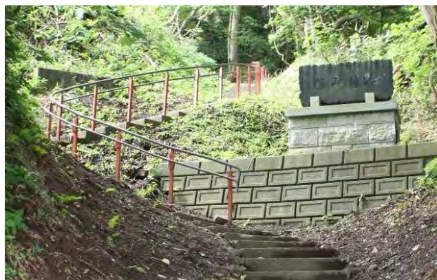
写真 4-92 大手物見跡横のステンレス製の手摺【H21 年度整備】 057
