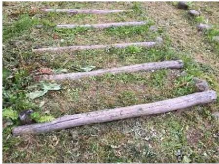
写真 4-73 腐食が進む木製階段 (丸太ステップ)【S58 年度整備】 041
