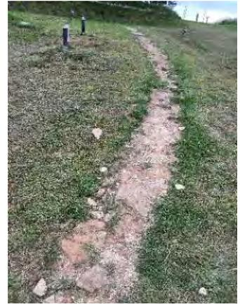
写真 4-72 劣化・破損が進んだ散策路【H13 年度整備】 041
