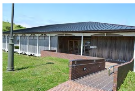
【勝山館跡ガイダンス施設】
