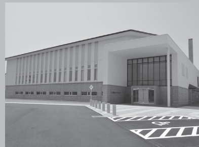
スポーツセンター施設建設費 11億3,250万円 （総事業費15億5,532万円） 平成26～30年度
