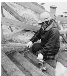
安全のため金具を取りつけている様子
