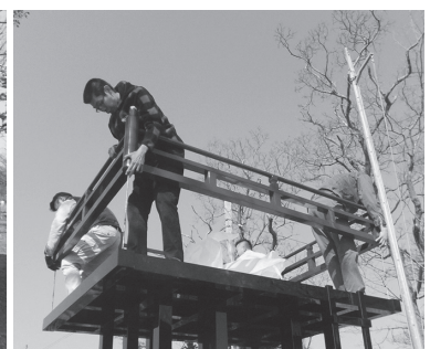
仕上げに、取付を行います。
