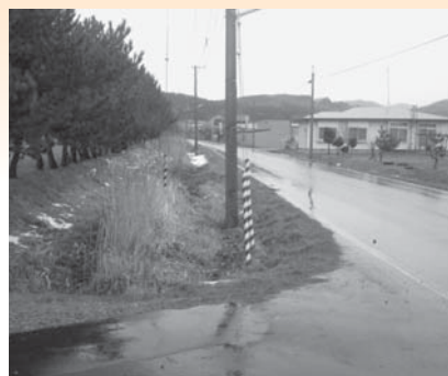
補修を行う町道豊留通学線
